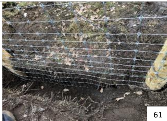
Untergrabungsschutz: Bodenanker (60) und Untergrabungsschutz: Zaun eingegraben (61)
